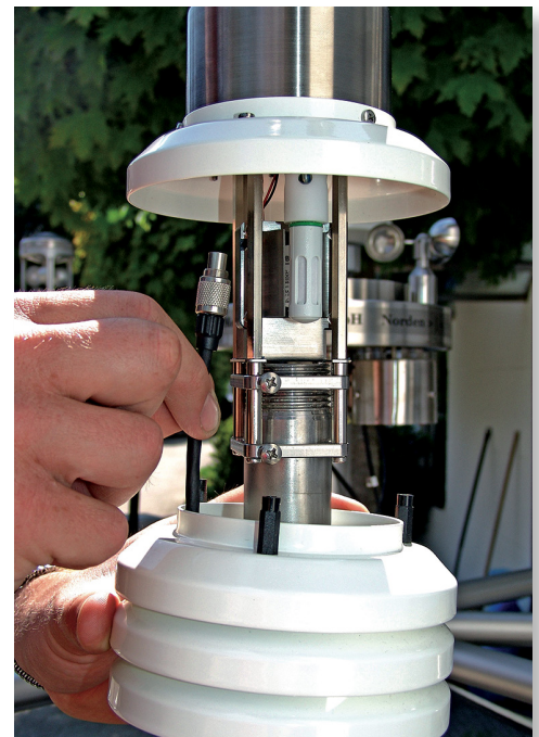
Montage einer Wetterstation
